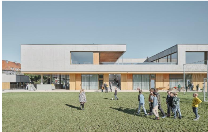
Volksschule Kaindorf an der Sulm Architektur: epps Ploder Simon ZT-GmbH Bauherrschaft: Stadtgemeinde Leibnitz © Schreyer David
