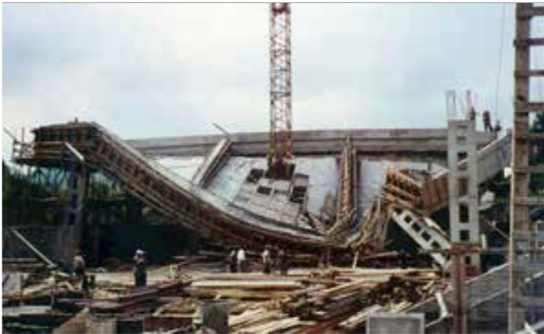
Der Deckenbereich eines Turnsaals brach beim Bau ein Foto © Privat
