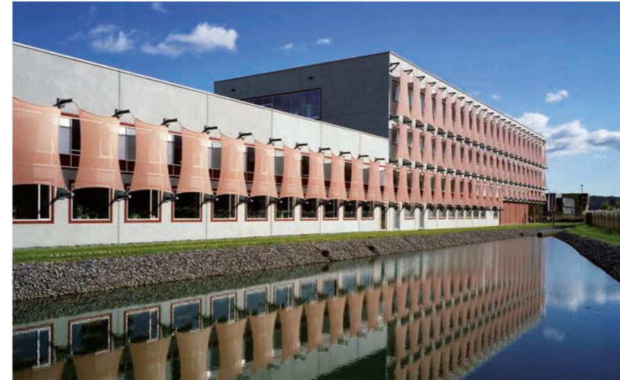
Der Neubau des Elin Motoren-Werks war nach Expansionen der vergangenen Jahre nötig geworden und vereint nun sowohl Verwaltung als auch Produktion in einem Kopfbau und der im rechten Winkel daran anschließenden, vierschiffigen und 240 Meter langen Werkshalle. Im Erdgeschoss des Bürogebäudes befinden sich ein Foyer mit Empfang und Bar, die Kantine sowie Besprechungsräume mit Zugang auf eine Terrasse. In den Obergeschossen gibt es um zwei
